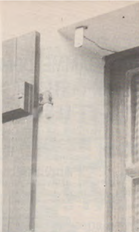
Un circuit séparé pour les volets garantit une sécurité très supérieure à celle apportée par une seule boucle de rupture
