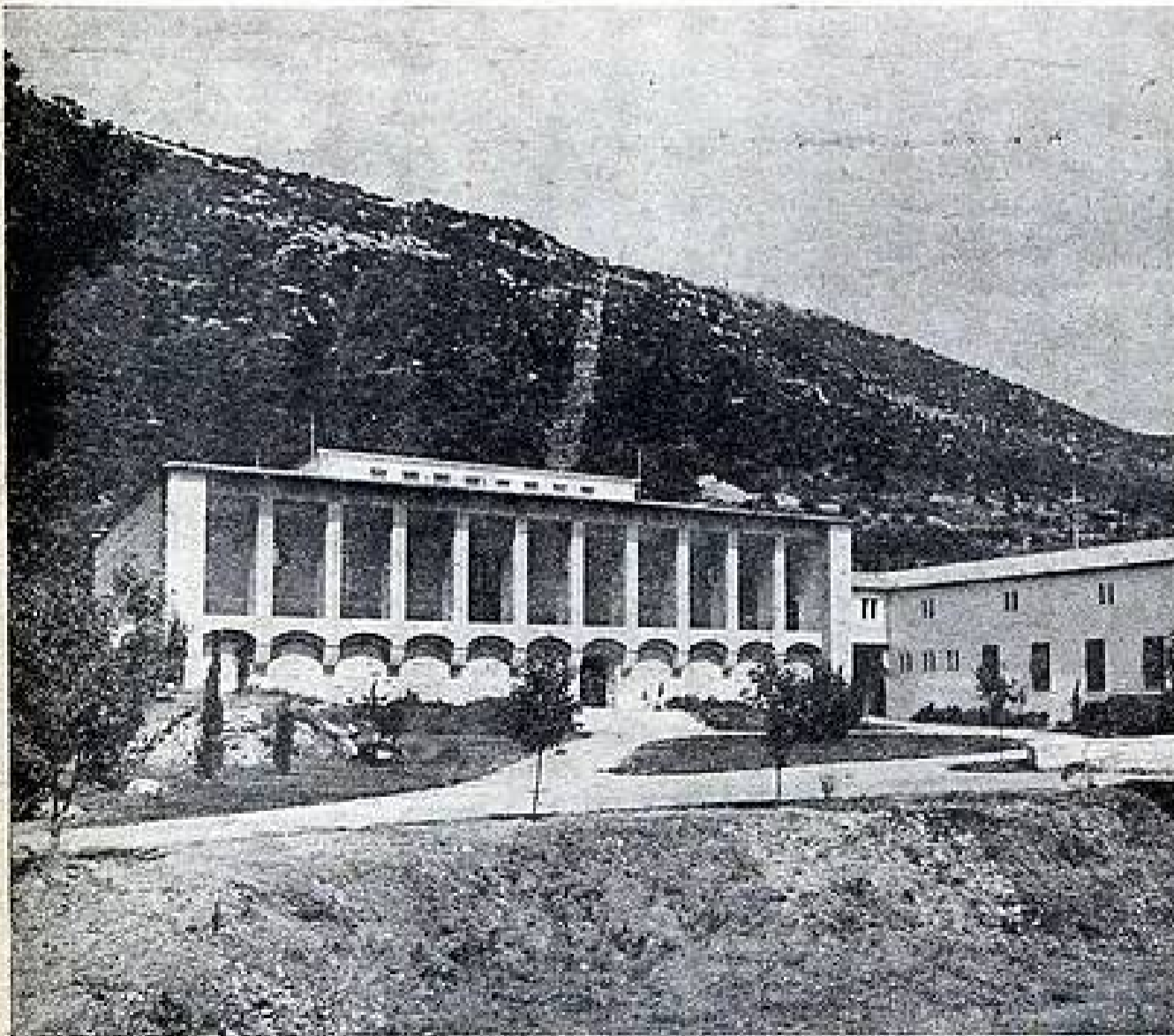
Le bâtiment des émetteurs. Derrière le feeder. On aperçoit le sommet du pylône d'antenne.
