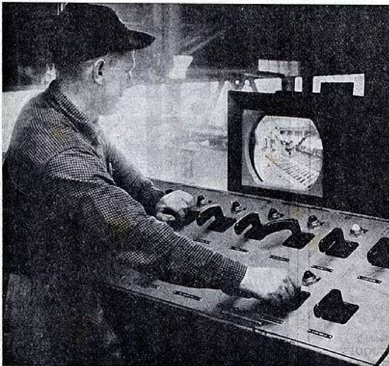
La fabrication automatique des tôles d'acier est commandée de cette cabine, grâce à un écran de télévision relié à neuf caméras installées en divers points de l'usine.
